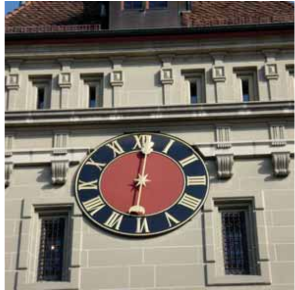
...et le cadran (de la façade ouest).
